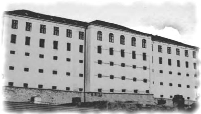
A Hosszú utcáiig (a mai Jókai utca) lenyúló épületben felül – az udvarszint felett – a gyűléstermeket is tartalmazó két szint, alul – a vár felszíne alatt – három börtönszint látható
